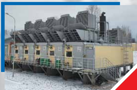
Блочно-модульный дизельный энергокомплекс гарантированного резервного электроснабжения 5 МВт (6,3кВ) на базе двигателей 8ЧН21/26.
